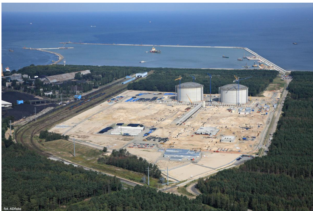
Fot. 3 Widok terminalu LNG.
