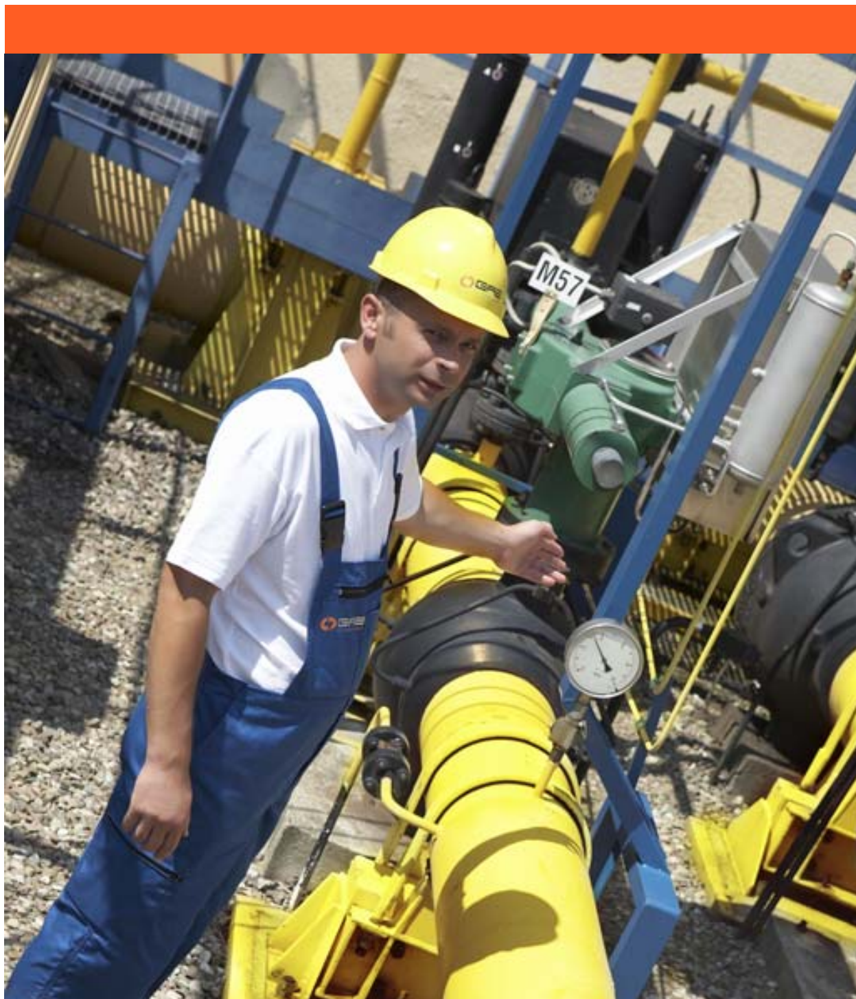
Tłocznia gazu w Rembelszczyźnie.
