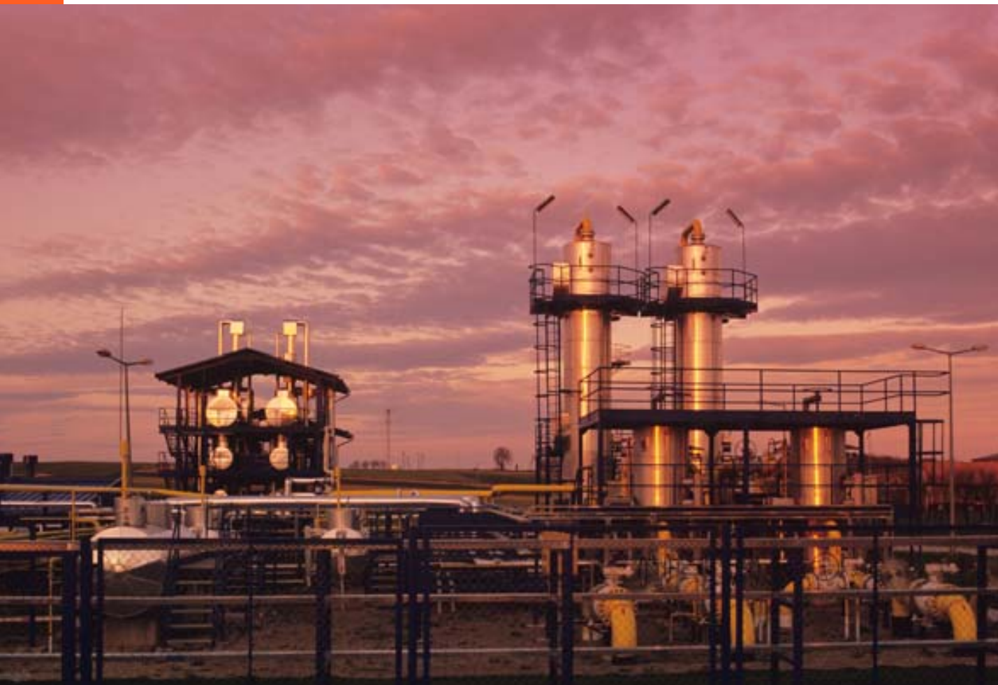
Osuszalnia gazu w Maćkowicach.
