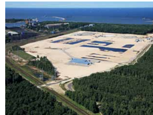
Terminal LNG w Świnoujściu w budowie
