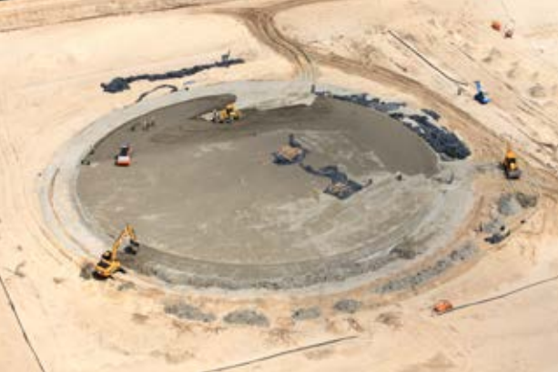
Postęp prac przy budowie zbiorników LNG Work progress during the LNG tanks construction 28.05.2011
