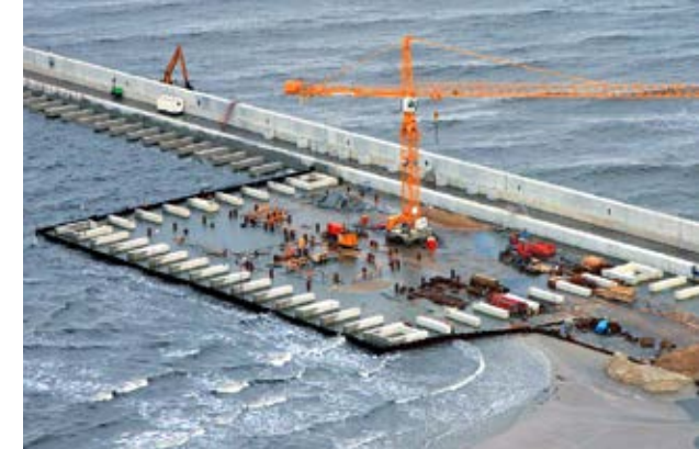
Postęp prac przy budowie platformy technologicznej Work progress during the technological platform construction 6.01.2012
