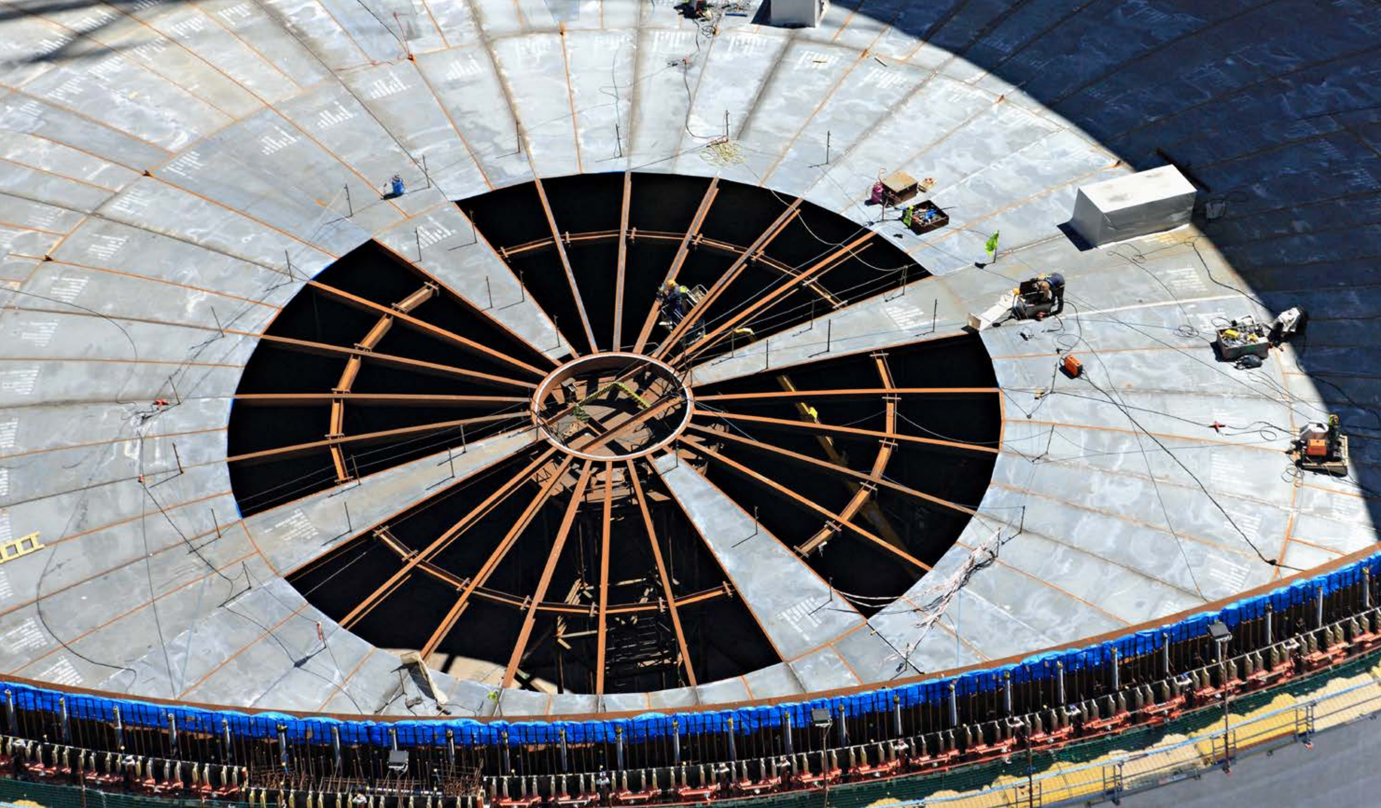
Prace przy konstrukcji kopuły zbiornika Work on the dome construction 23.03.2013
