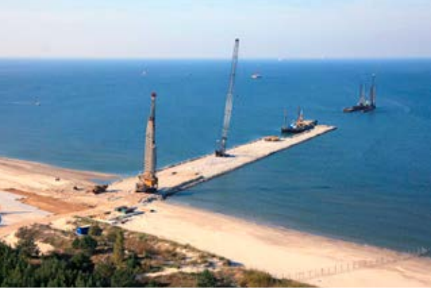
Postęp prac przy budowie falochronu Work progress during the breakwater construction 23.09.2010
