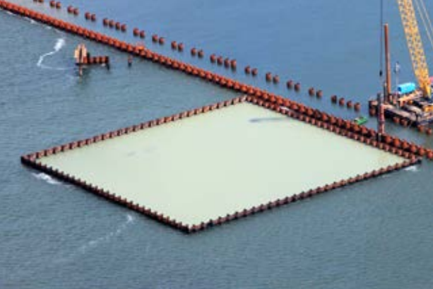
Postęp prac przy budowie platformy rozładunkowej Work progress during the unloading platform construction 28.05.2011
