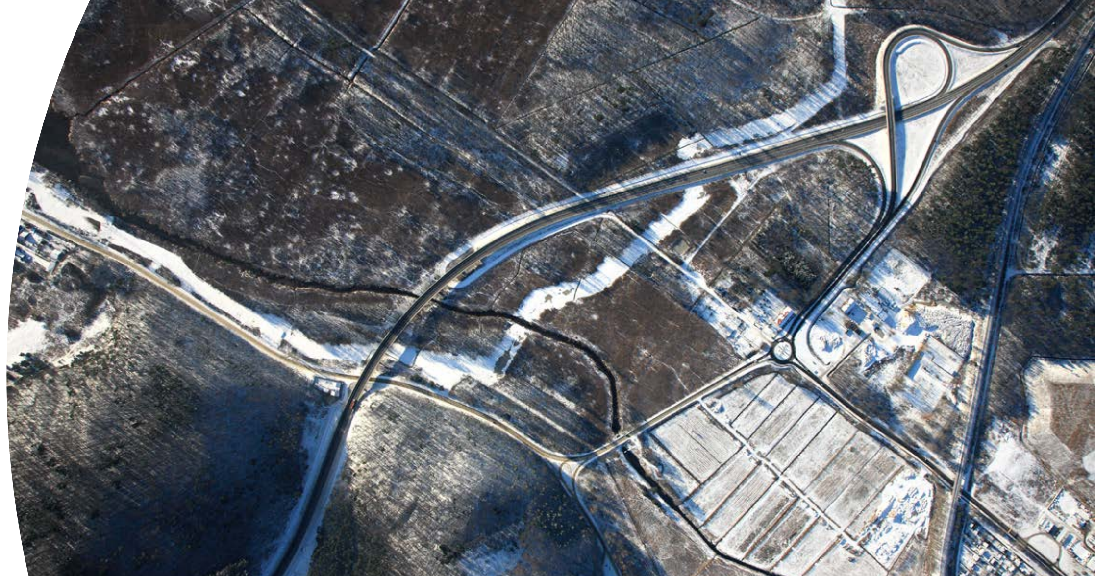
Trasa gazociągu Gas pipeline route 2014
