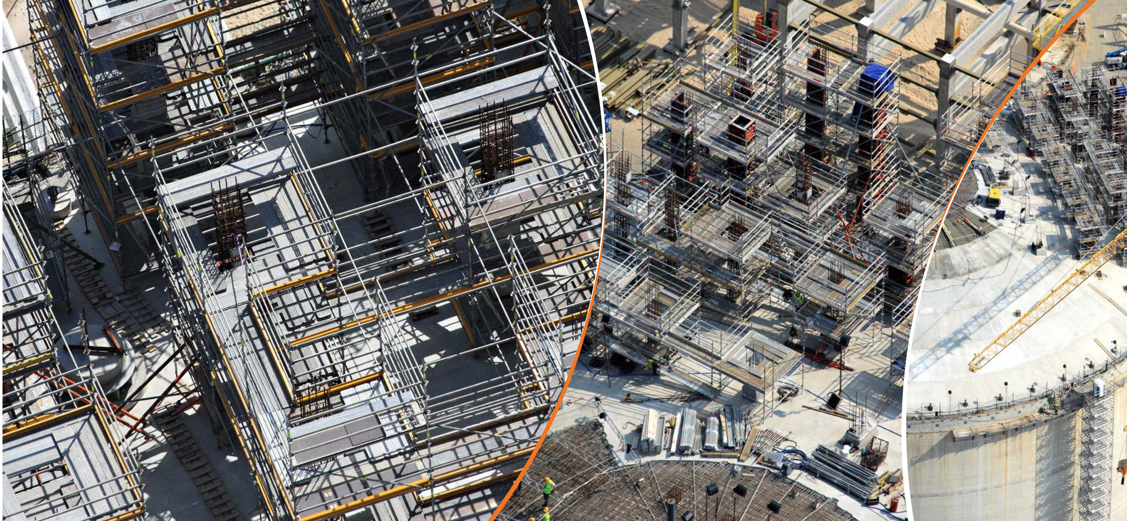
Rusztowania na kopule zbiornika LNG Scaffolding on the LNG tank dome 22.04 – 23.05.2013
