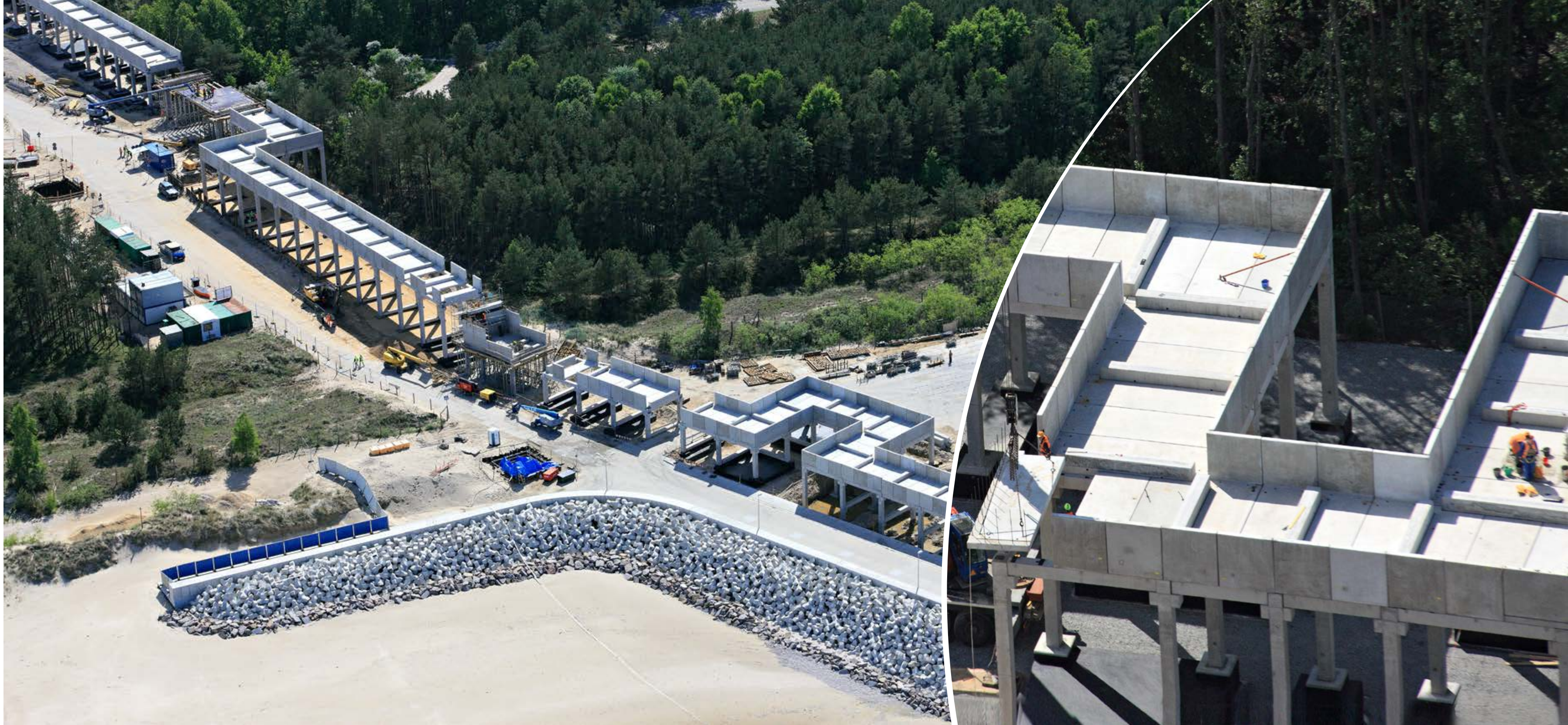
Budowa estakady rurociągu LNG LNG gas pipeline trestle bridge construction 23.05.2013
