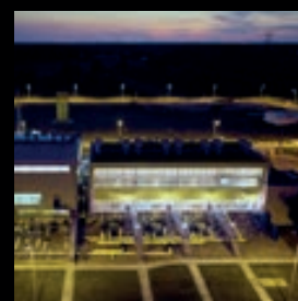
Węzeł Rembelszczyna Rembelszczyna junction
