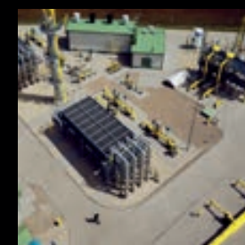
Tłocznia Jeleniów II Jeleniów II Compressor Station
