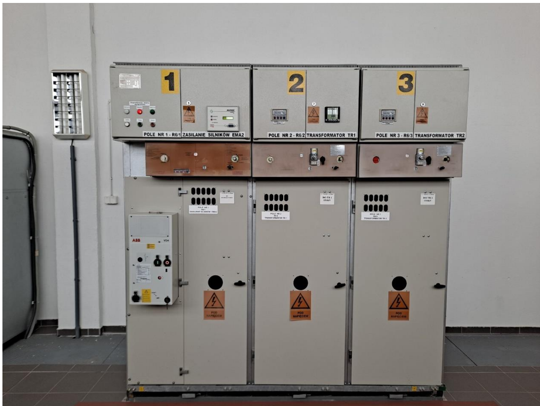
1.9. Rozdzielnica SN 6kV
