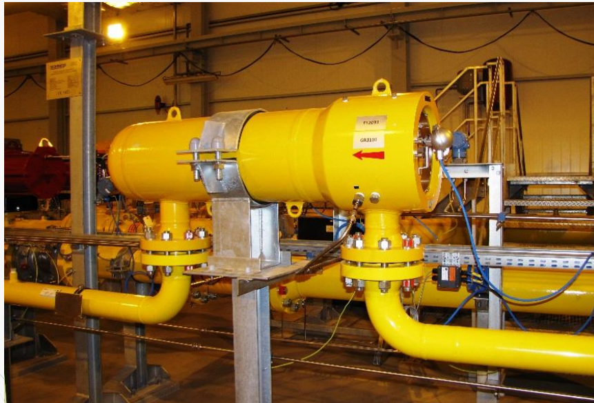
gazomierz rotorowy typu IRPP G250 ( Q_{min}=2\text{m}^3/\text{h} ; Q_{max}=400\text{ m}^3/\text{h} )
