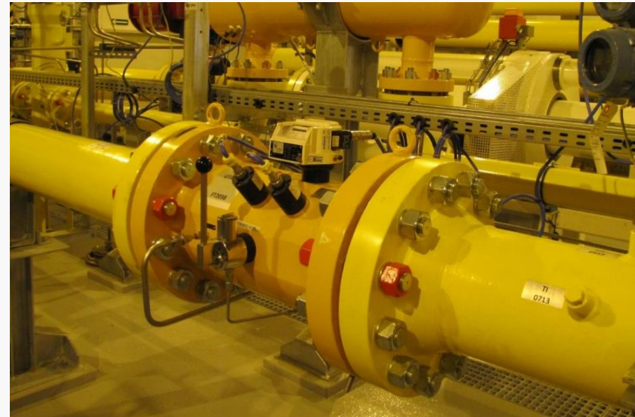
gazomierz turbinowy typu SM-RI-X G1000 ( Q_{min}=80\text{m}^3/\text{h} ; Q_{max}=1600\text{ m}^3/\text{h} )
