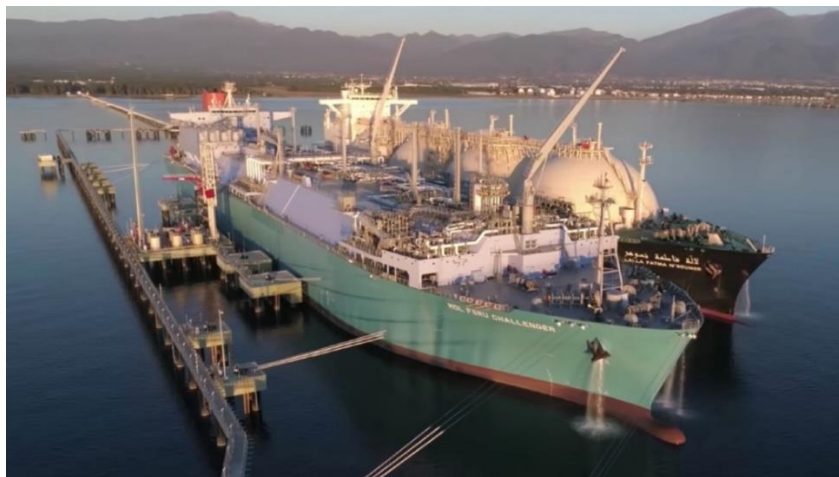
Rys. 3. Przykład zacumowanej do nabrzeża jednostki FSRU i zacumowanego gazowca
