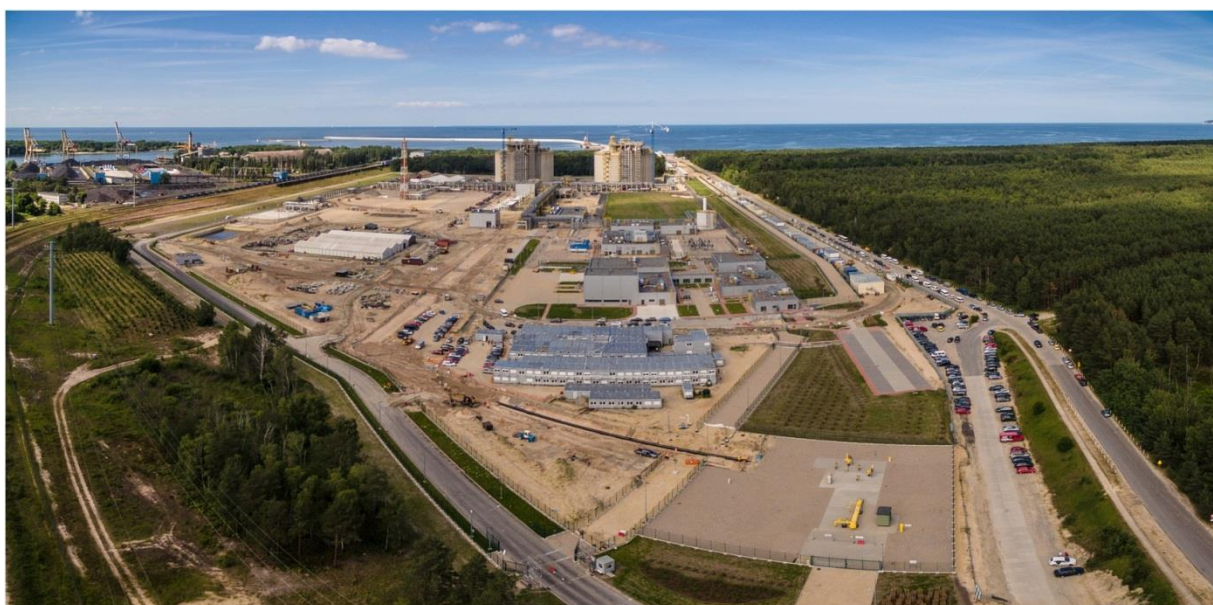
Fot. Widok terminalu LNG – lipiec 2015 roku
